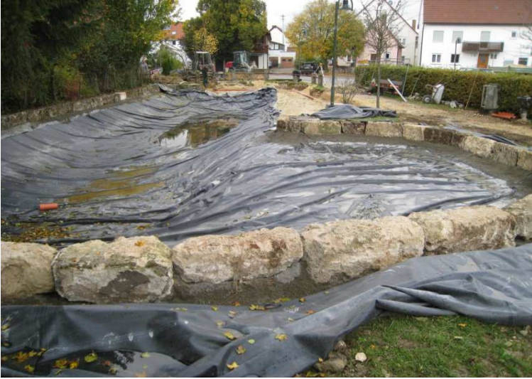
Die neue Folie ist schon eingebracht
