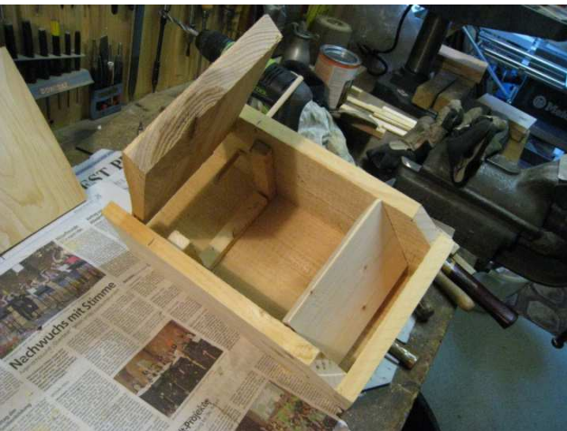
Fledermauskasten im Bau
