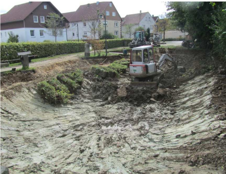
Sanierung der Donnstetter Hüle im Herbst 2015: Ausbaggern des Schlammes
