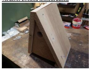
8. Abstandsunterlage entfernen; Loch vorbohren (3mm) für "Wiener Reiber" (4mm
